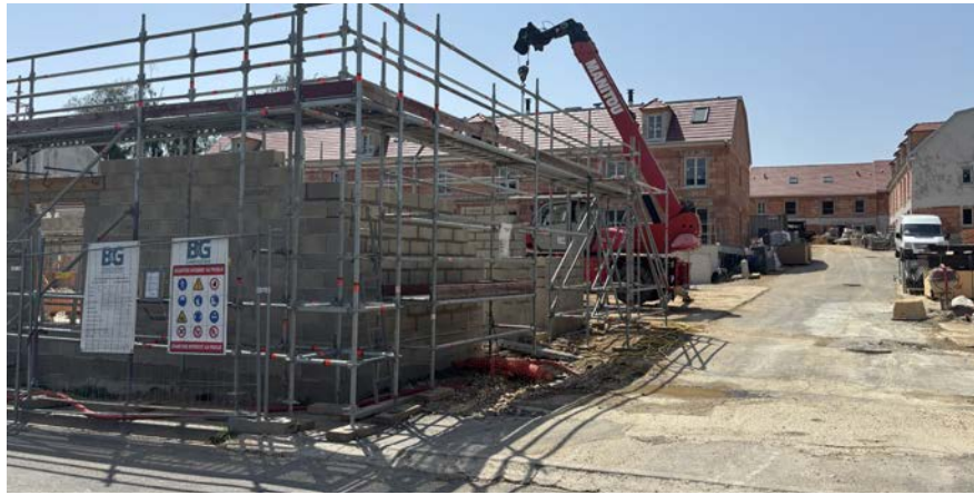
A Lardières, 26 logements collectifs et huit maisons sont en construction.
