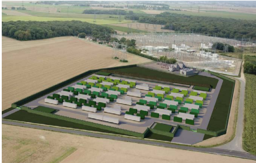
Un site de stockage d'électricité par batterie va voir le jour à Neuilly-en-Thelle. Le chantier vient d'être lancé.
