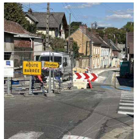
Le chantier de renouvellement des conduites d'eau potable entraîne la fermeture de la rue Jean-Jaurès.
