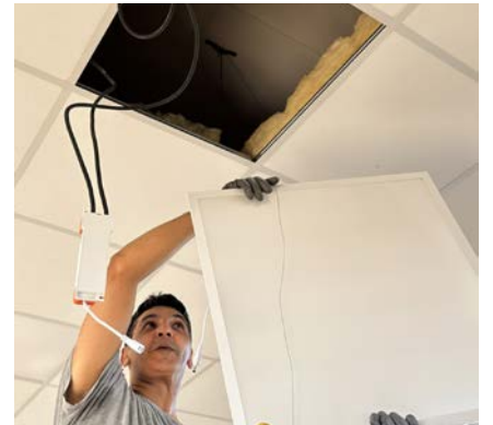
A l'école Roger-Salengro, 15 salles de classes ont vu leurs 95 pavés néon remplacés par des panneaux LED
